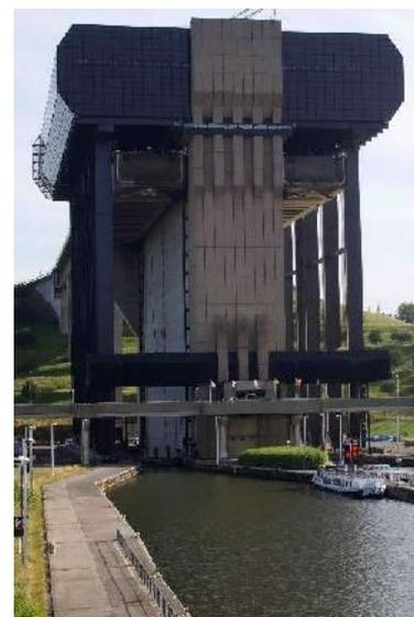
Les 2 bacs de 112 x 12 m évoluent indépendamment l'un de l'autre et peuvent accepter des bateaux de 2 000 t<sup>1</sup>. Chacun pèse 8 000 t<sup>2</sup> et est suspendu à 144 énormes câbles<sup>3</sup>, dont 112 supportent 8 contrepoids de 1 000 t, les 32 autres étant entraînés par 4 moteurs électriques de puissance relativement faible (510 kW, soit l'équivalent d'un moteur d'une F1).
